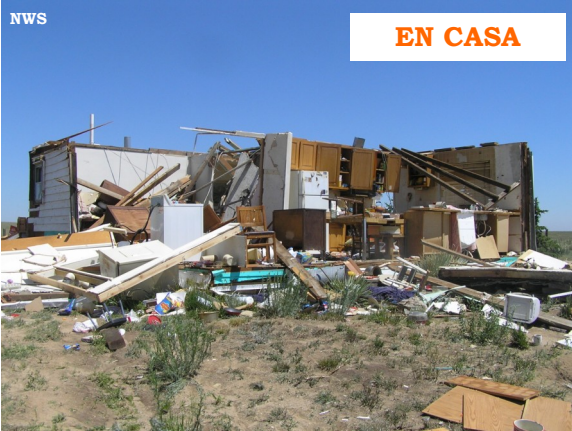
Tornado EF2 causa daños a una casa en el condado Elbert, Colorado
